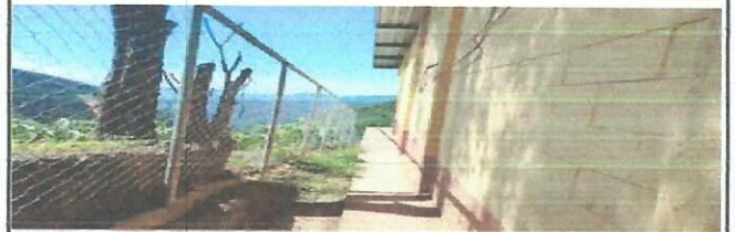
Foto 4: Renovación del portón de ingreso del establecimiento y reparación de cuneta del contorno del establecimiento para la conducción de agua pluvial.
